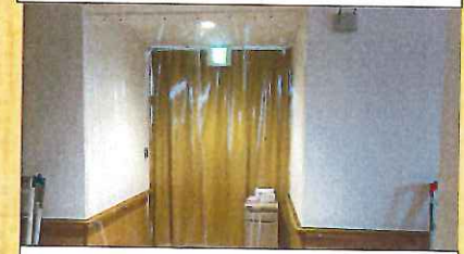
ビニールシートで拡散 防止・間仕切り対策
