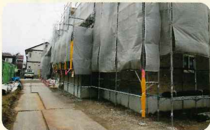
グループホーム外壁工事
