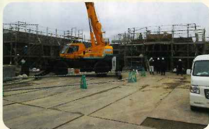
総合センター躯体(コンクリート打設)
