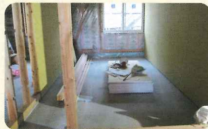
グループホーム内装工事
