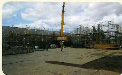
総合センター型枠組工事
